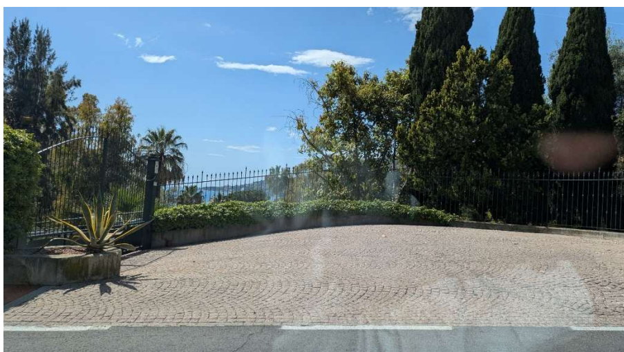
Accesso ai box della residenza – Via Cavour
